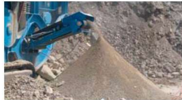
ανακύκλωση αποβλήτων κατεδαφίσεως
