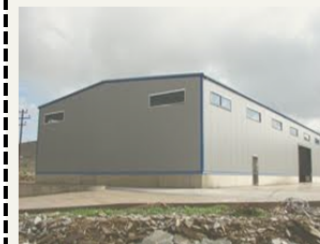
Ενεργειακά Βιοτεχνικά και Εμπορικά Κτίρια ΓΣΕΒΕ
