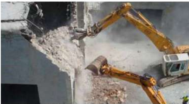
κατεδάφιση παλαιών ανενεργών κτιρίων στο εργοστάσιο Ελευσίνας
